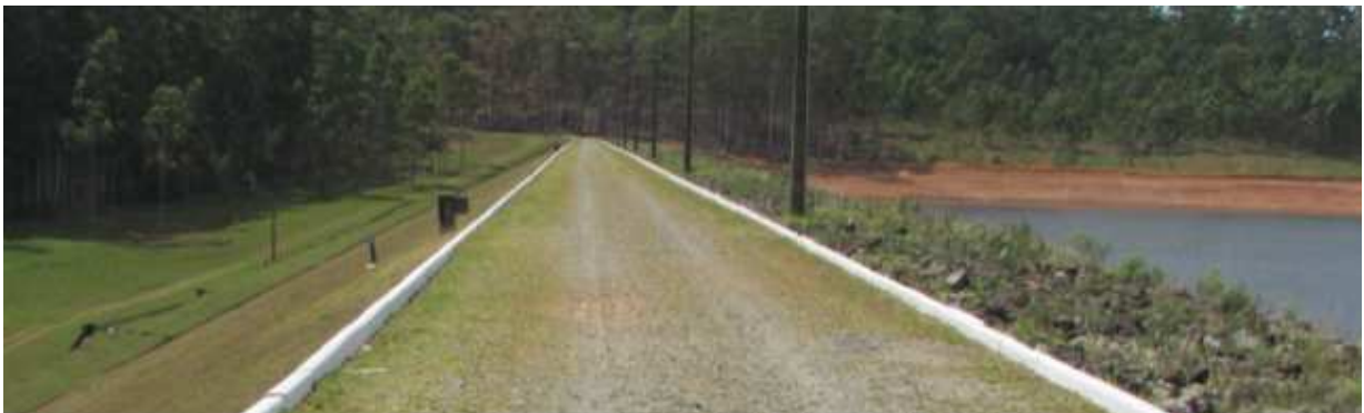
FIGURA 1.5 VISTA DA CRISTA DA BARRAGEM.
