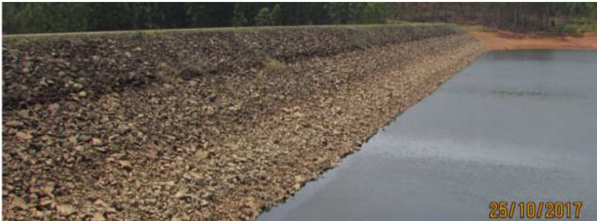
FIGURA 1.4 VISTA DE MONTANTE PODENDO-SE OBSERVAR O RIP-RAP DA BARRAGEM.
