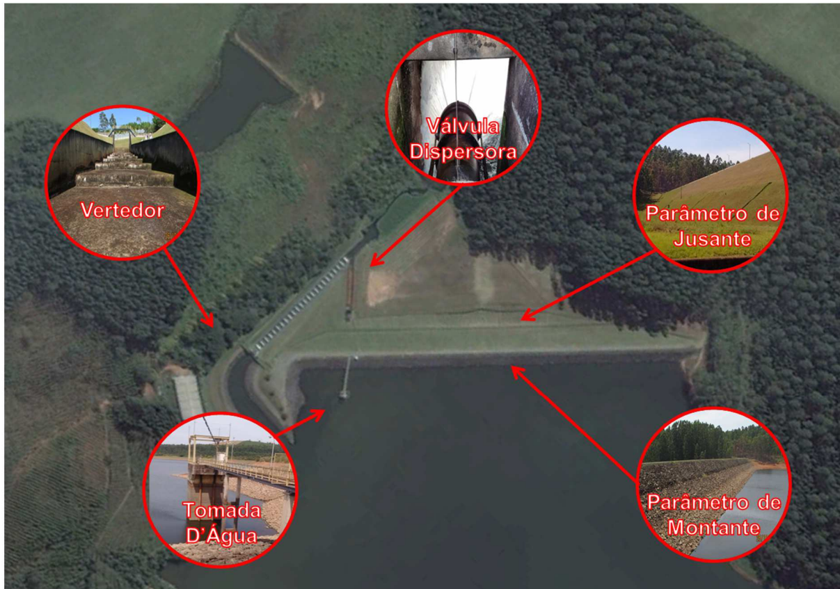
FIGURA 1.1 PRINCIPAIS ELEMENTOS DA BARRAGEM
